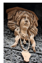
Włocławek, kamienica przy ulicy Piekarskiej
